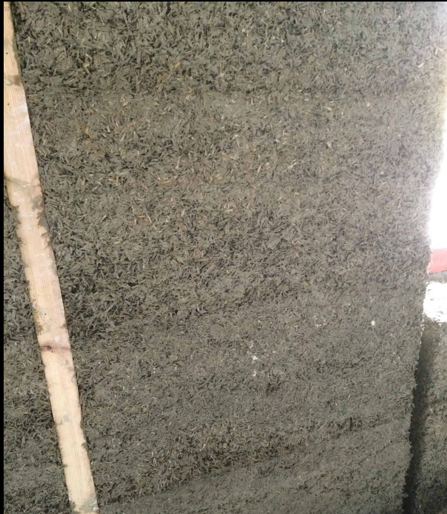
Béton de chaux chanvre
